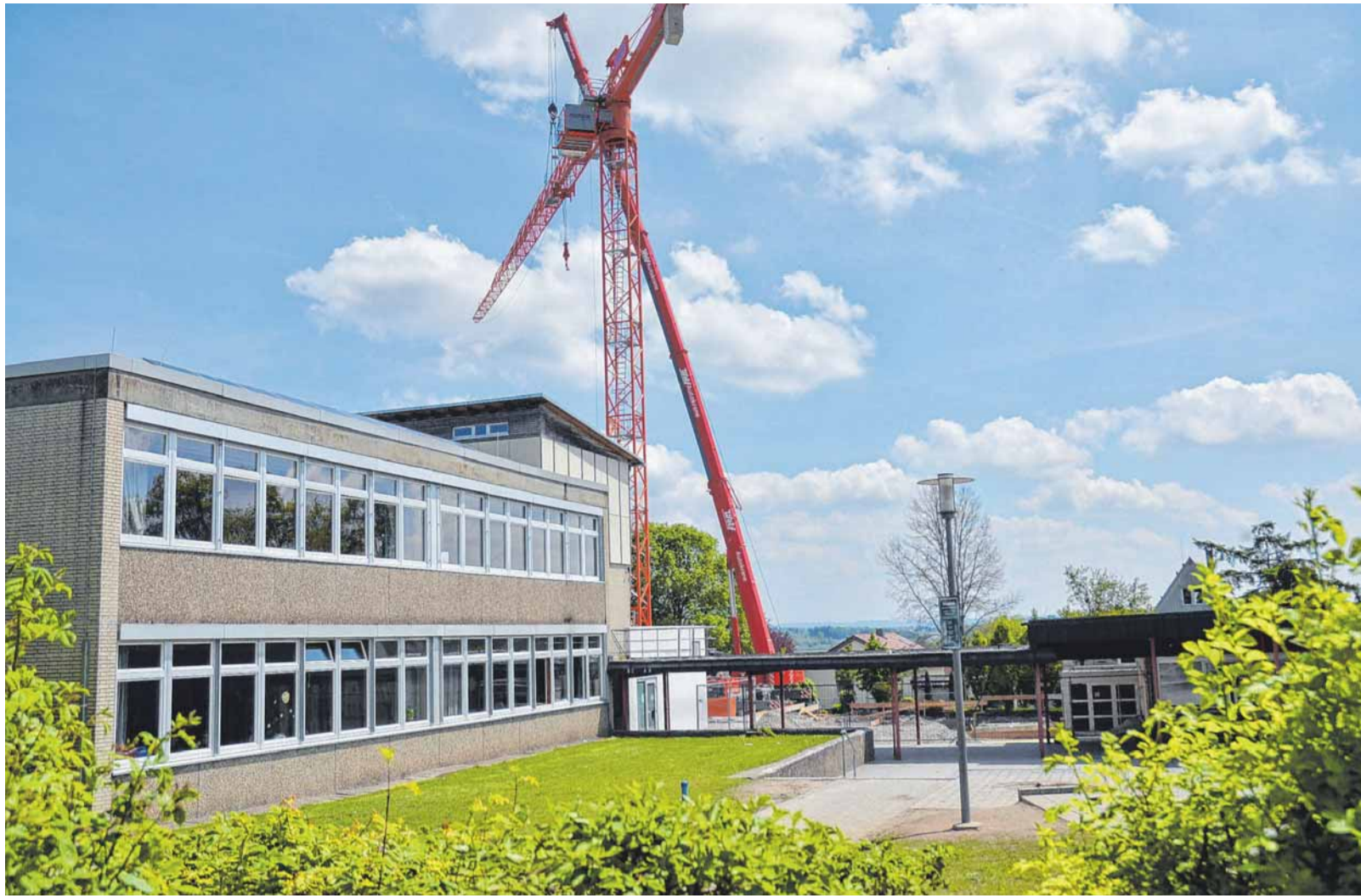
Auf dem Schulhof der Herzog-Philipp-Verbandsschule wird bereits der Kran für den neuen Zwischenbau errichtet. Nun müssen auch noch die Dächer der Turnhalle und des Musiksaals möglichst bald saniert werden. FOTO: JULIA FREYDA
