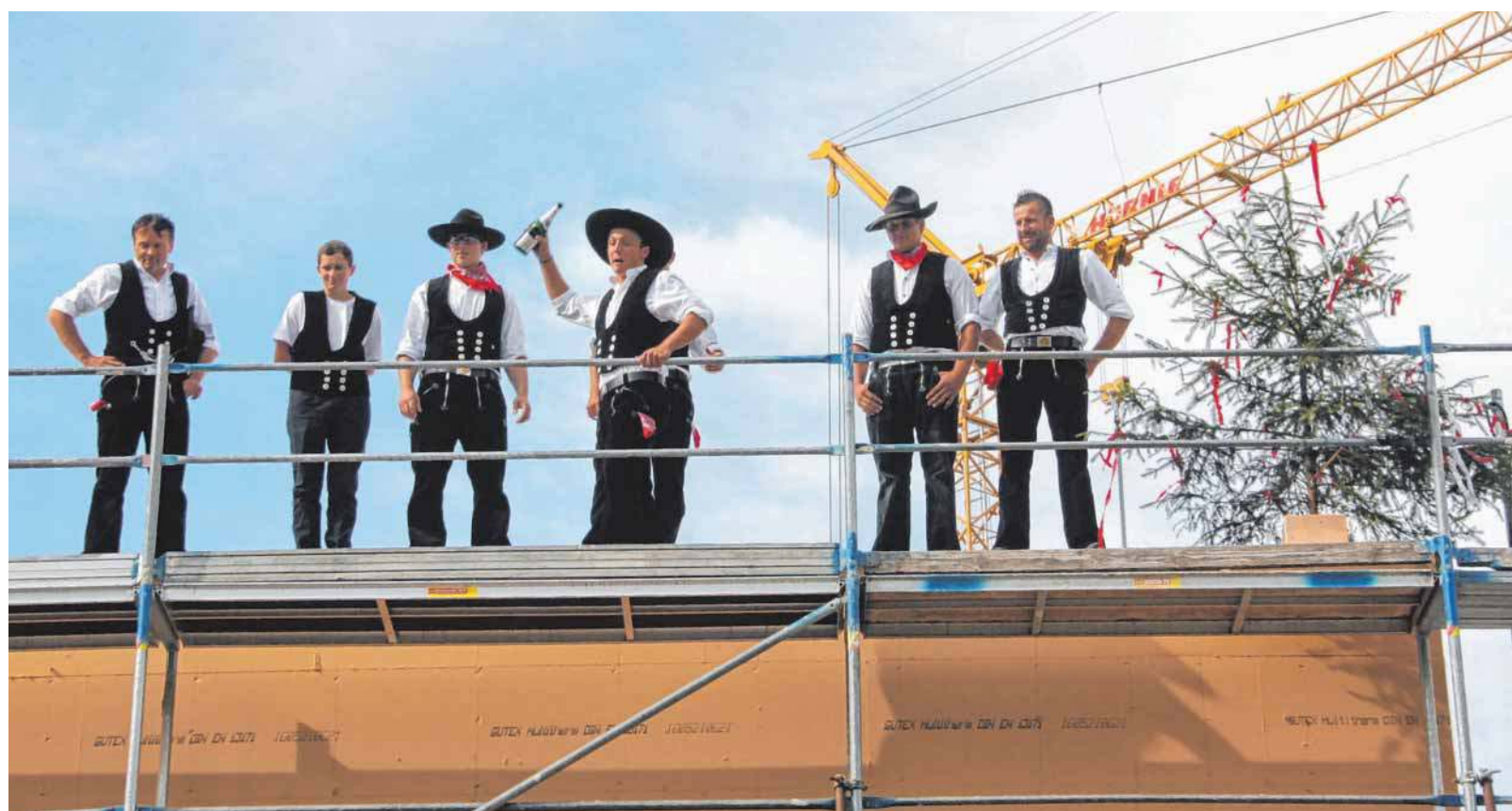
Der Richtfestbaum steht, die Flasche und das Glas gingen zu Bruch: Das bedeutet Glück und Segen für die neue Turnhalle in Amtzell.
