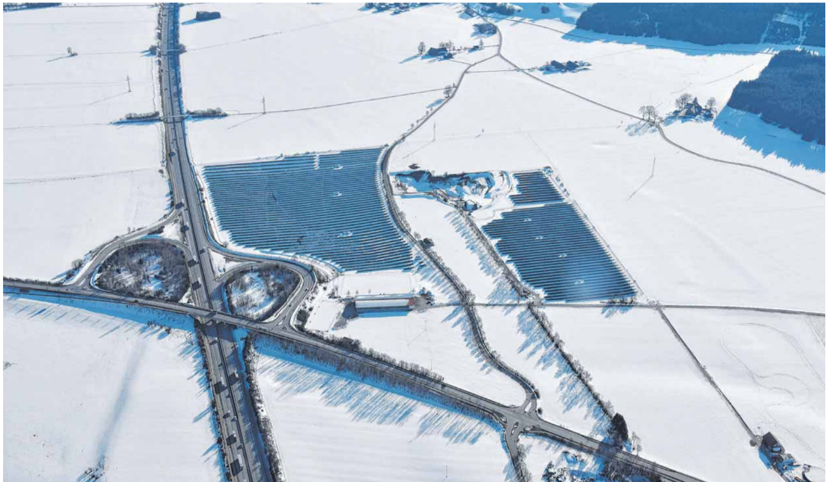
Das über ein Drittel des Leutkircher Strombedarfs laut Ministerium vor Ort regenerativ aus Sonne, Wasser und Biomasse erzeugt wird, war mitentscheidend für die Auszeichnung. Das Bild zeigt die Solarparks westlich von Leutkirch auf der Haid. FOTO: HEINZ MAUCH
