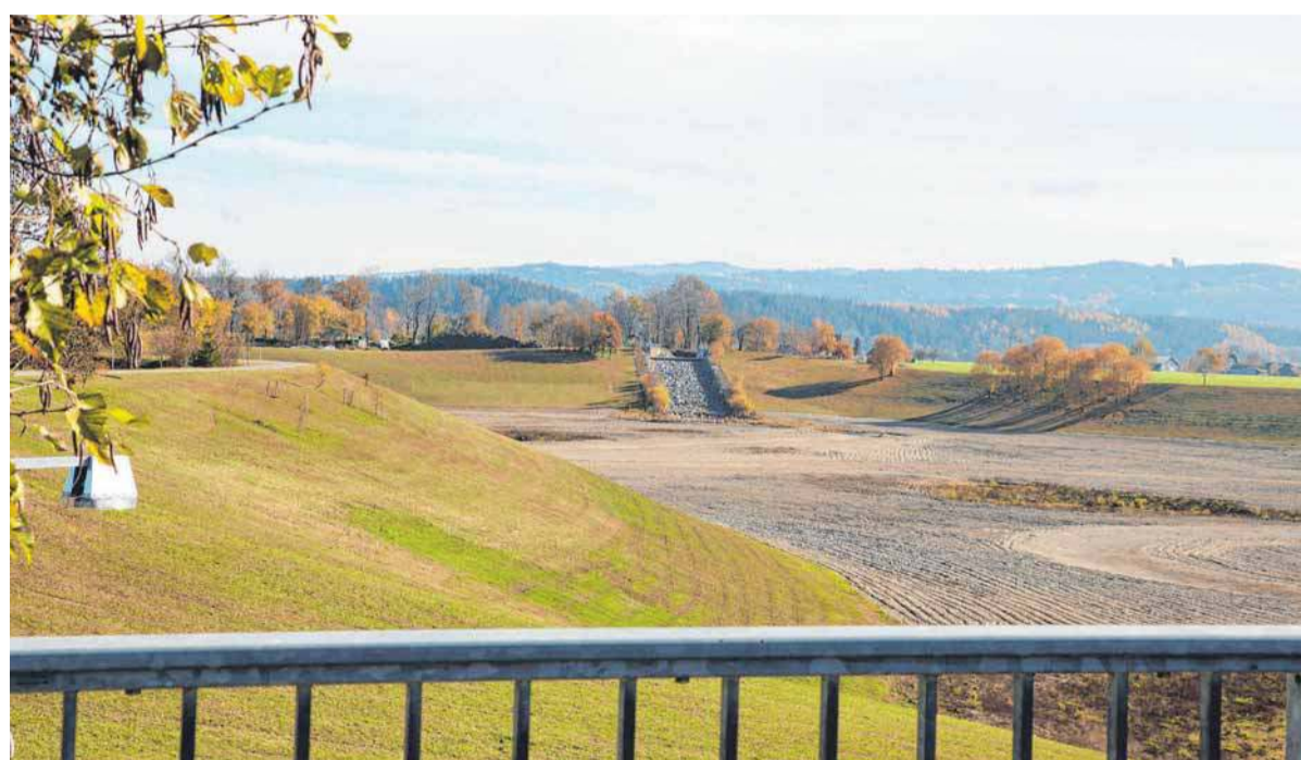
Bis zu einer Million Kubikmeter Wasser passen in das Urlauer Rückhaltebecken. FOTO: UWE JAUSS
