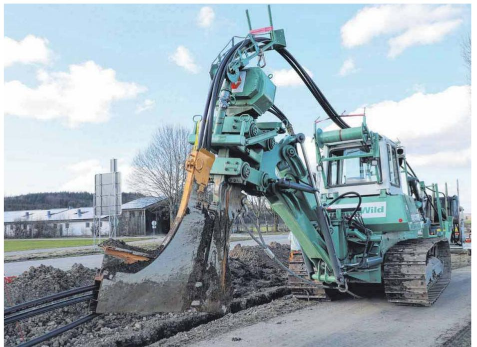
Die erste Kabeltrasse führt von Bonlanden nach Berkheim. Mit einem Kabelpflug werden die Leerrohre Meter für Meter verlegt.
