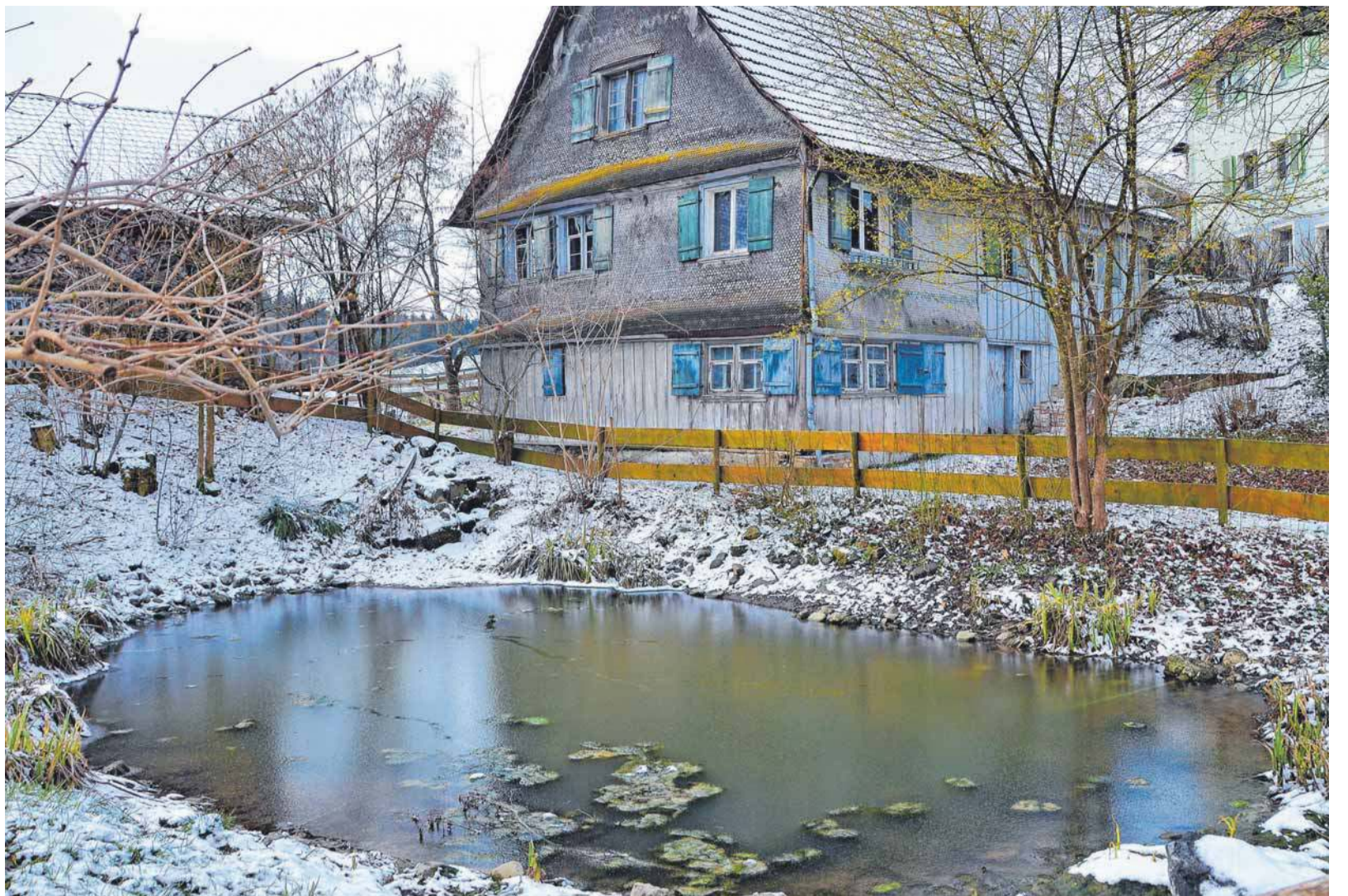
Am Dorfweiher in Deuchelried werden Bauarbeiten nötig.
