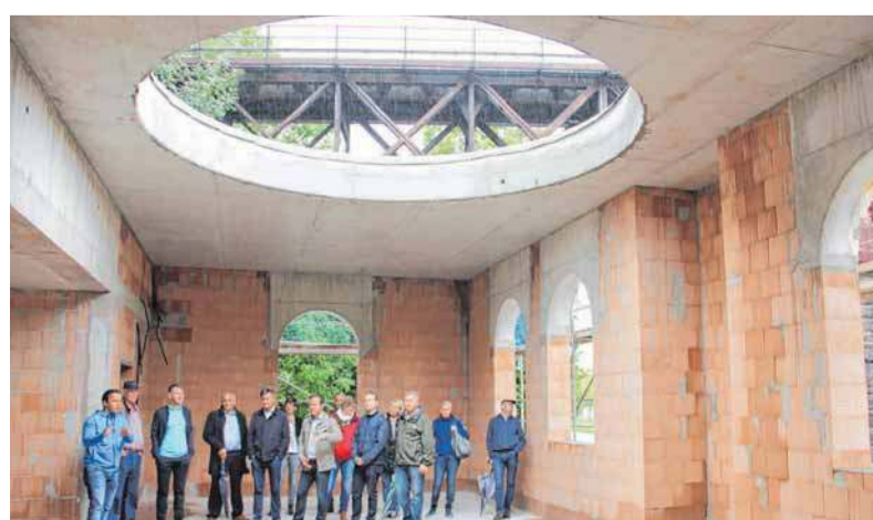
Die CDU-Delegation besichtigt den künftigen Gebetsraum des türkischen Begegnungszentrums. Auf das Loch in der Decke kommt eine Glaskuppel, im Hintergrund ist die Eisenbahnbrücke über die Argen zu sehen. FOTO: BEE
