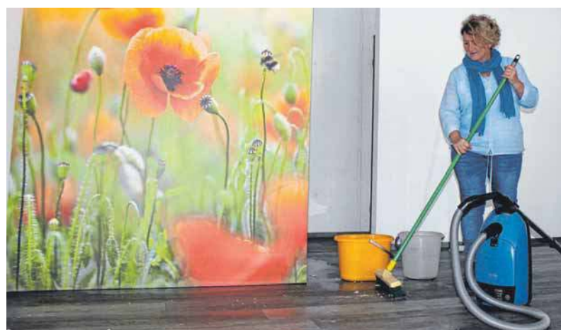
Wasser tropft von der Decke, daher hat Petra Melzer Wassereimer aufgestellt. FOTO: WOLFGANG HEYER
