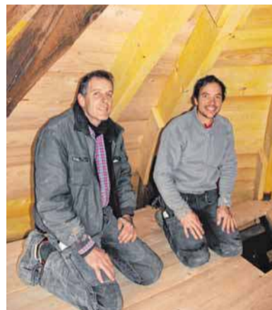
Thomas Schele (li.) und Guillermo González mussten Teile des Tragwerkes des Dachs und die Verschalung ersetzen. FOTO: ANDY
